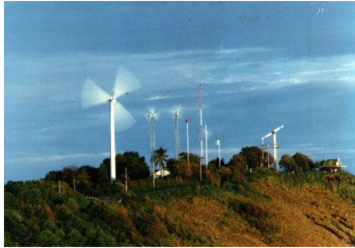
ภาพที่ 4.12 สถานีผลิตไฟฟ้าจากพลังงานลมร่วมกับระบบเซลล์แสงอาทิตย์ของการไฟฟ้าฝ่ายผลิต ที่แหลมพรหมเทพ จังหวัดภูเก็ต ที่มา: Siripuekpong et al, 2002)
